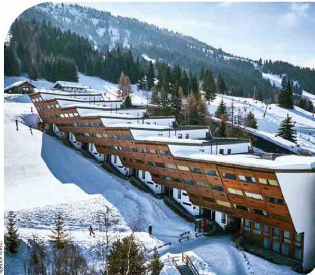
Architecture. La Cascade, immeuble iconique de la station des Arcs.
